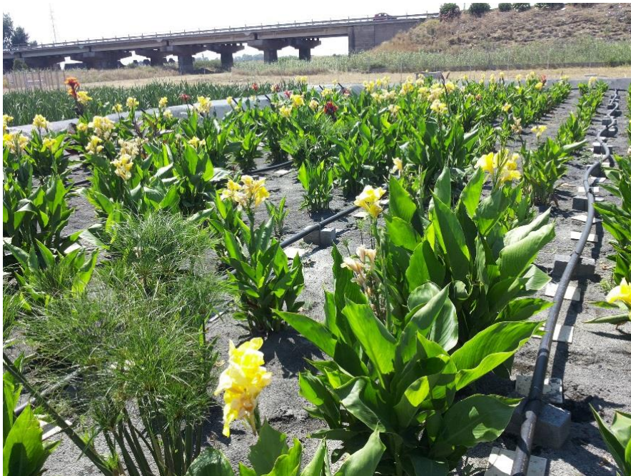
Sistema a flusso sommerso verticale (V-SSF)
